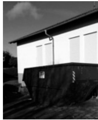
Einige Schuttcontainer waren in der Zwischenzeit bereits nötig
