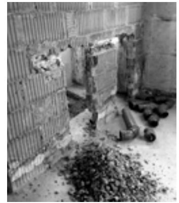
Die bisherigen Räume wurden komplett entkernt
