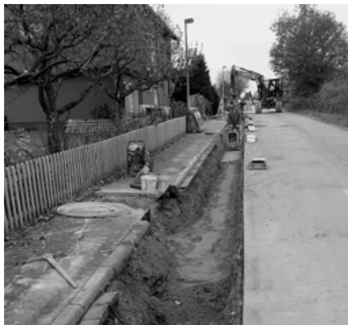
Blick in den Leitungsraben am Lindenhofweg
