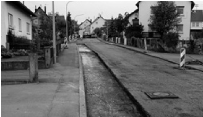
Straßensanierung Breiter Weg
