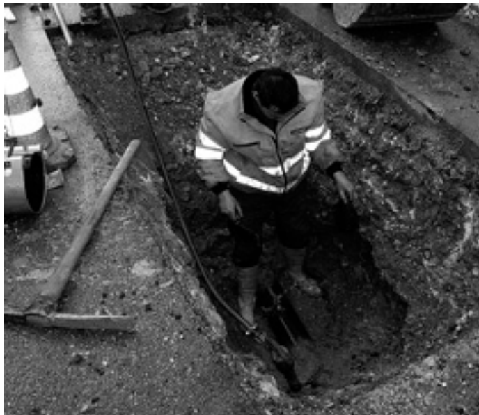
Bauhofmitarbeiter Siegfried Heinzmann bei der Reinigung der Rohrbruchschadstelle
